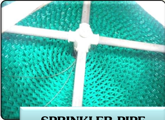
SPRINKLER PIPE
